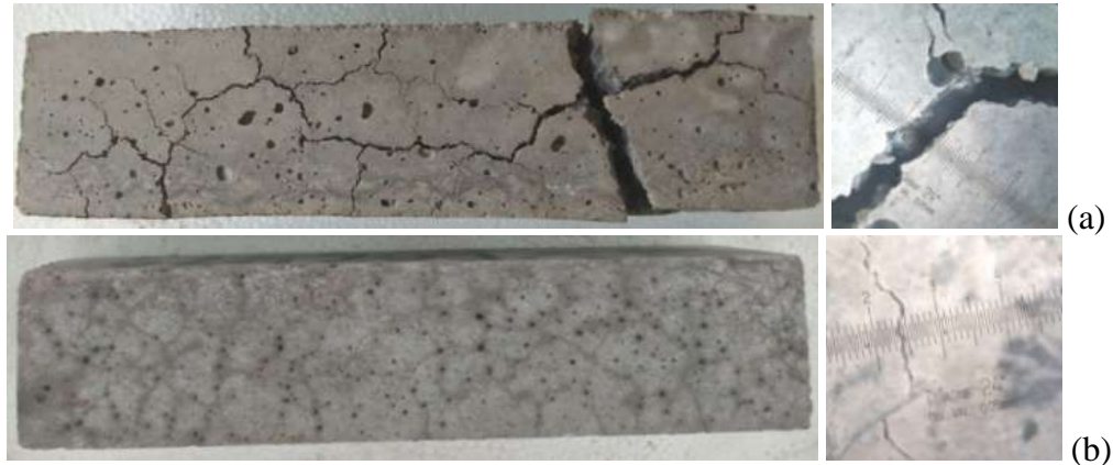
Figure 11 : Fissuration des éprouvettes des mortiers, (a) mortier sans additions minérales (b) mortier avec additions minérales
