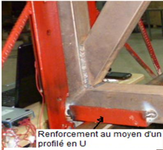
Figure 8 : Renforcement de la poutre au niveau de l'appui
