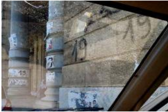
Figure. 2 : État de façade de l'hôtel de ville, lors des élections législatives du 10 mai 2012. Source : L'auteur.
