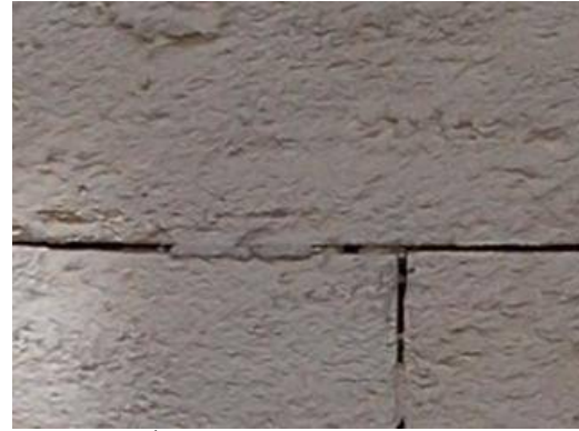
Figure. 3 : État de la façade de l'hôtel de ville, après l'opération de sablage, source : L'auteur, 2012.
