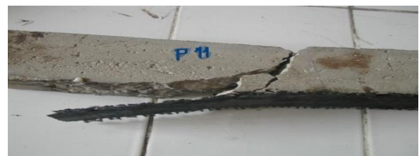
Figure16. Rupture de la poutre P11
