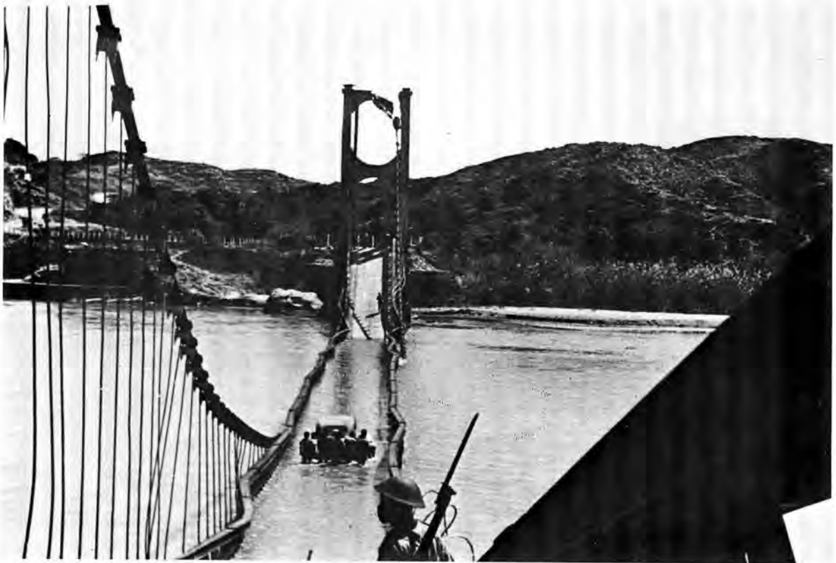
Die Betsiebokabrug — nog bruikbaar na die sabotasie.
