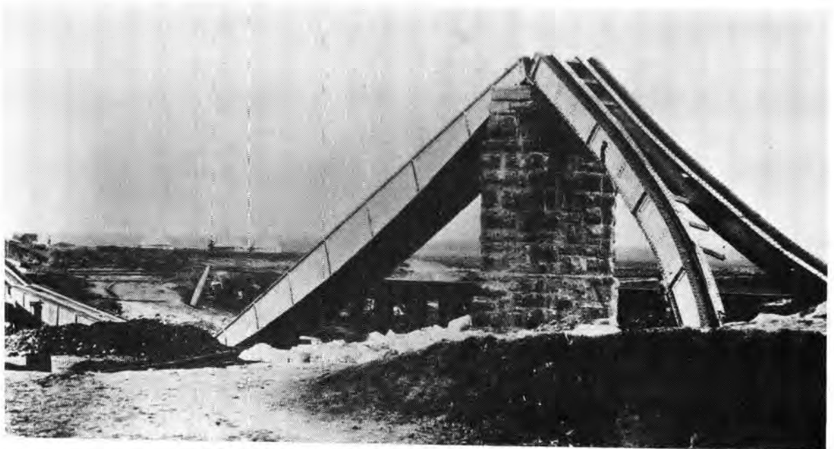
Brug by Bronkhorspruit beskadig gedurende die Anglo-Boereoorlog
