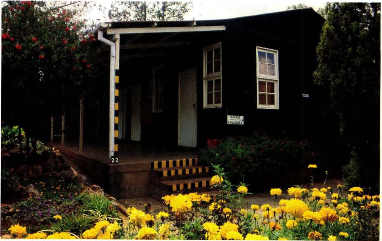
Foto 11 'n Konglomeraat van boukonstruksies op die perseel van Kommandement Noord-Transvaal is verteenwoordigend van hoe daar sedert sy ontstaan op Voortrekkerhoogte gebou is. (Sien ook foto 13 op volgende bladsy).
