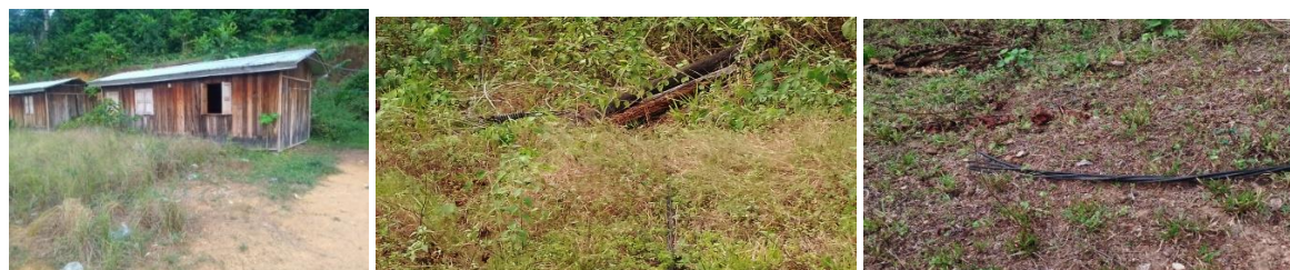
Figure 8 : de gauche à droite, maisons inhabitées abandonnées à Malongo, poteau électrique et câbles électriques endommagés (Source, Atouba, février 2024).
