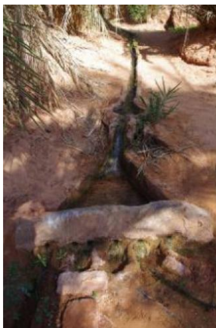
Fig.13. Kasria d'une foggara de l'oasis de Timimoun de la wilaya d'Adrar, (Photo. Remini, 2019)
