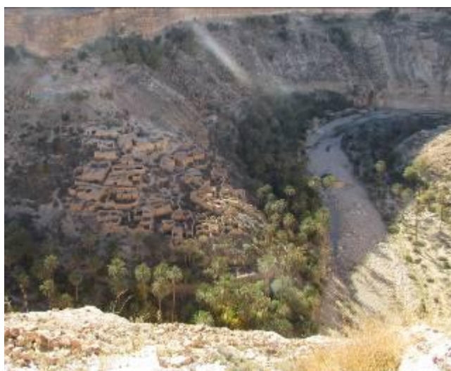
Fig.8. Région de Ghassira : Un exemple construction des ksour pour éviter inondations (Photo. Auteurs, 2015)
