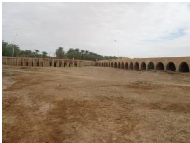
Fig.10. Ahabs Foussa de l'oasis d'El Guerrara destiné au partage des eaux de crues, (Photo. Remini, 2014)
