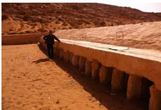
Fig.11. Tissanbadh de l'oasis de Ghardaïa destiné au partage des eaux de crues, (Photo. Remini, 2010)
