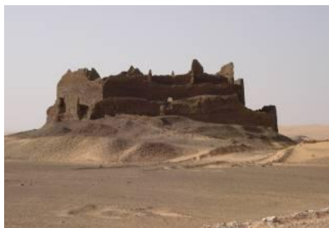
Fig.15. Un des ksour de Timimoun abandonné suite à l'assèchement de ces foggaras, (Photo. Remini, 2008)
