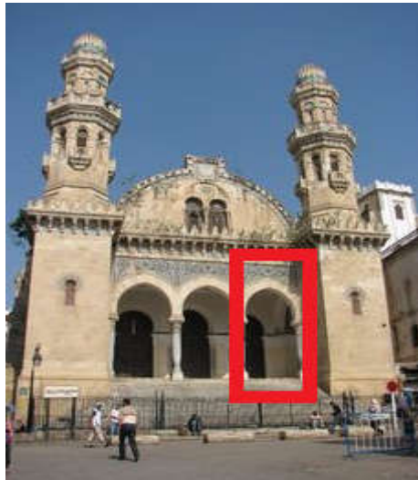
Fig.5. Module de l'arcade du porche d'entrée de la mosquée de Ketchaoua à Alger
