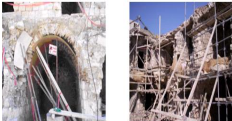
Fig.7. Renforcement des parties en voie de disparition [10].
