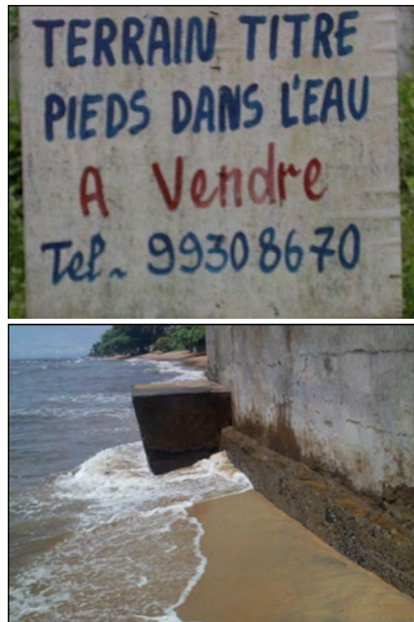
Fig. 15A, 15B : Les constructions en bordure de mer.
