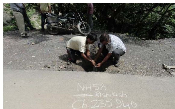
(d) Test Pit to Determine Pavement Layer Thickness
