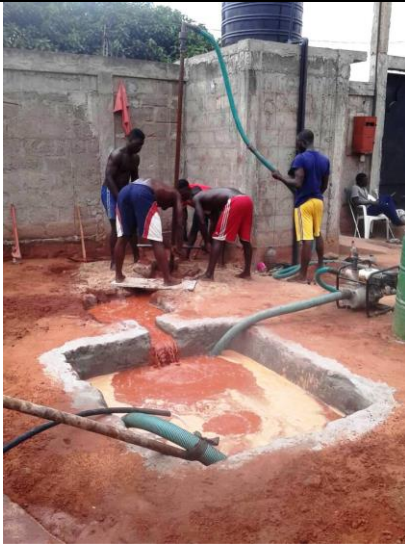
3a Forage manuel en cour de réalisation
