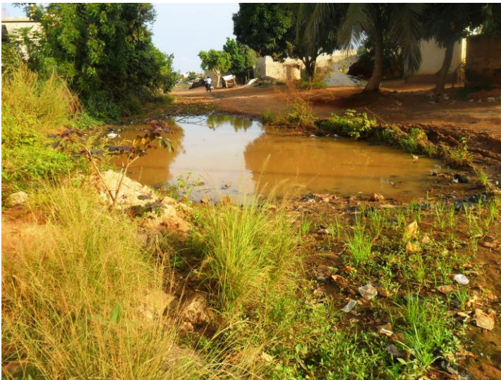
3c Eau stagnante sur une rue de Vakpossito
