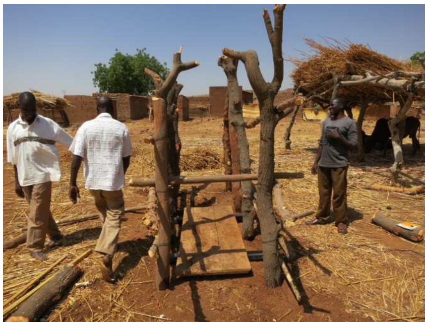
Photo 1 : Couloir de contention à base de matériaux locaux.
