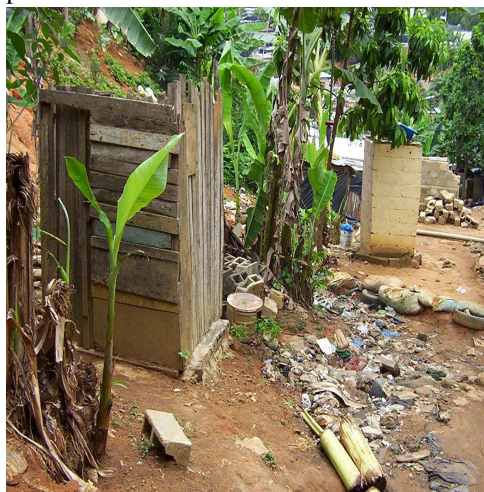
c : Latrines sèches en amont des forages dans les quartiers précaires de la Zone Est.
