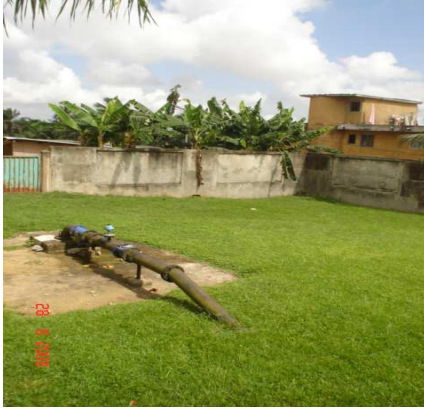
a : Habitations situées à proximité des forages à la Zone Nord.
