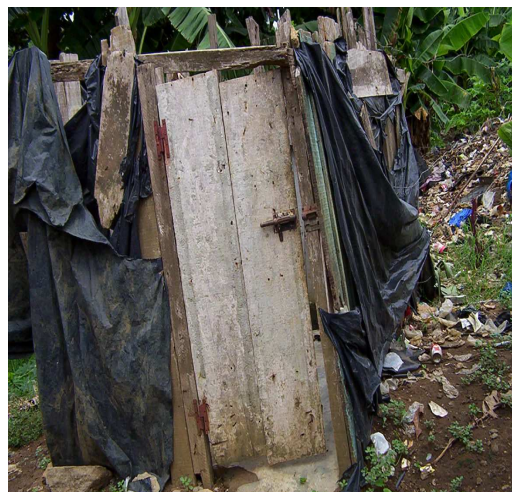
d : Latrine dans les périmètres rapprochés des forages situés à la Zone Est.
