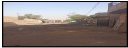
Photo N°02 : Une rue dégradée en terre de ce tramé
