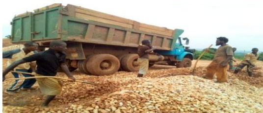
Photo 5 : Chargement de gravier à la pelle à Ayomi Prise de vue : Awé, mars 2020
