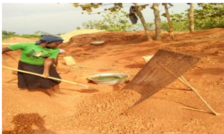
Photo 2 : Tamisage de gravier sur le site de Zohoudji Prise de vue : Awé, mars 2020
