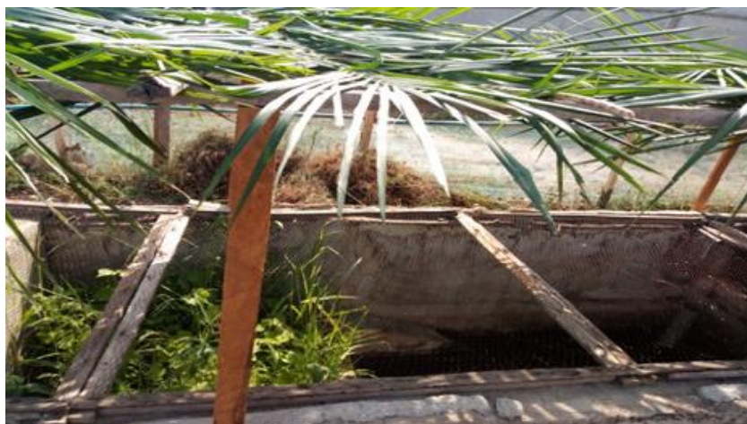
Figure 3 : Vue partielle d'un bac bétonné de 3,96 m 3 à la station de l'APDRACI (Photo Kéita, 2020).
