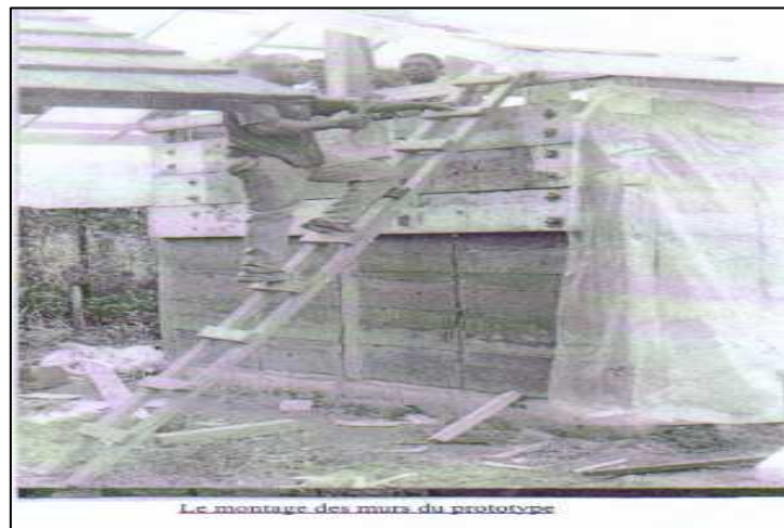
Figure 13 : Mise en œuvre des murs et leur protection
