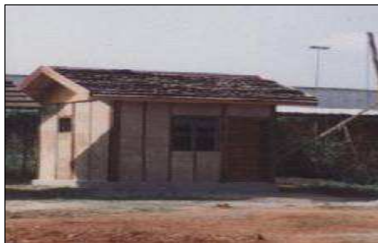
Figure 14 : Le prototype quelques jours après sa construction
