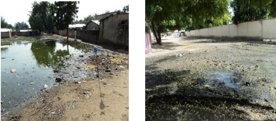
Photo 2 : Stagnation des eaux 48 heures après un événement pluvieux dans la ville de Maroua
