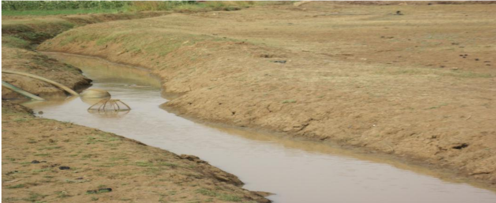
Figure 3 : canalisation pour l'irrigation
