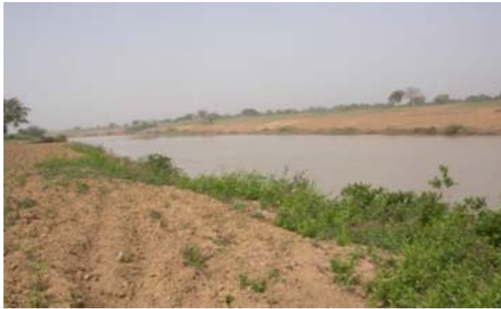
Figure 5. Etat dégradé des berges de la rivière Oti
